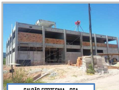
GALPÃO FITOTECNIA - CCA
